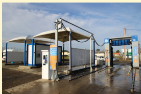
La station de lavage entièrement rénovée
